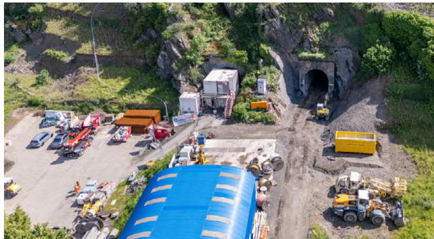
Abb. 3: Dieselloks haben auf der neuen Strecke ausgesiedet und werden durch elektrische Triebwagen ersetzt. Damit die Oberleitungen auch im Saffenburg Tunnel Platz finden, muss dessen Boden um einen Meter abgesenkt werden.
